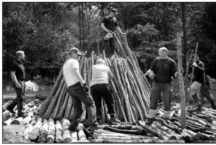
Byggandet av milan i full gång!
